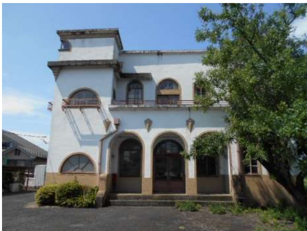
正面からの建物の様子
